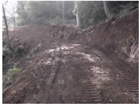
〔写真〕 開設が進む森林作業道の状況
