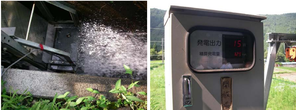
写真9-1 米子水車①設置状況
