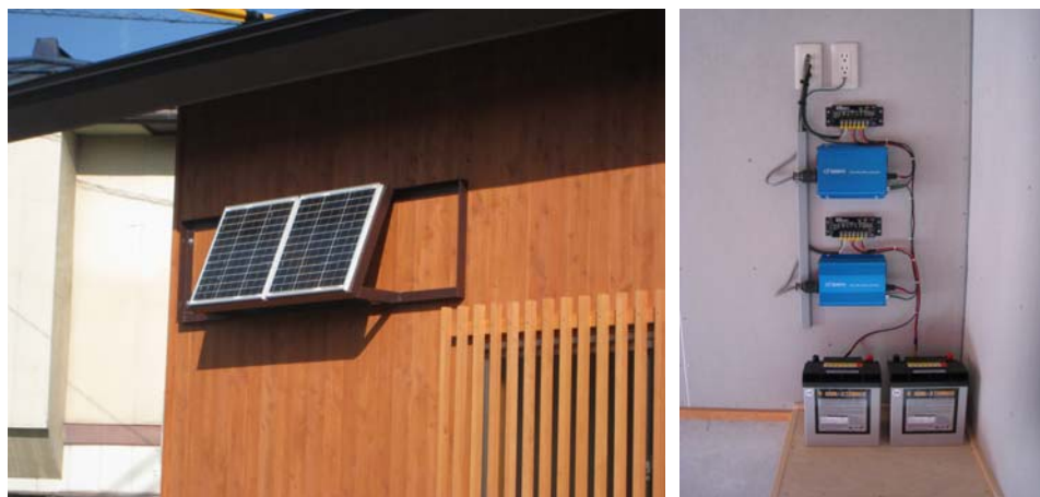
図 7-31 平林消防車車庫 太陽光発電
