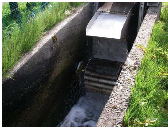
写真9-2 米子水車②設置状況
