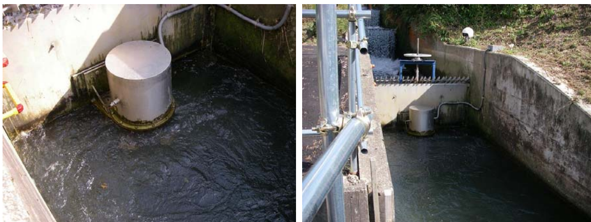
図 7-1 小水力発電導入事例（野沢温泉村終末処理場付近）
