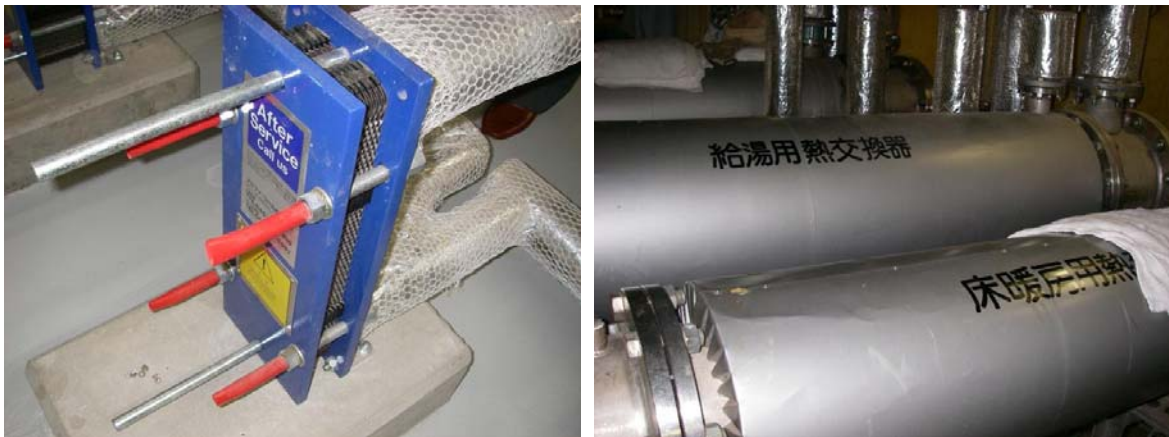
図 7-14 温泉施設における熱交換器導入事例（山ノ内町）
