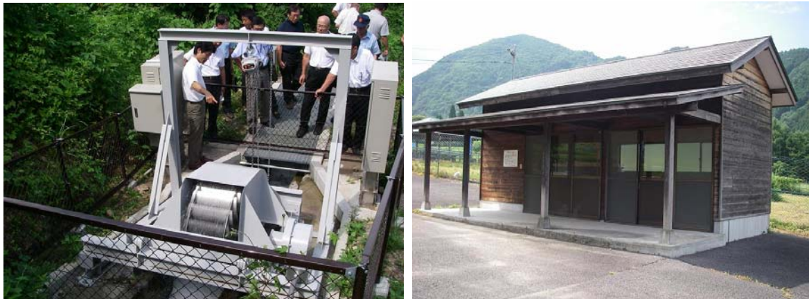
写真9-3 急流工水車設置状況（左）、電力供給先の農作物乾燥施設（右）
